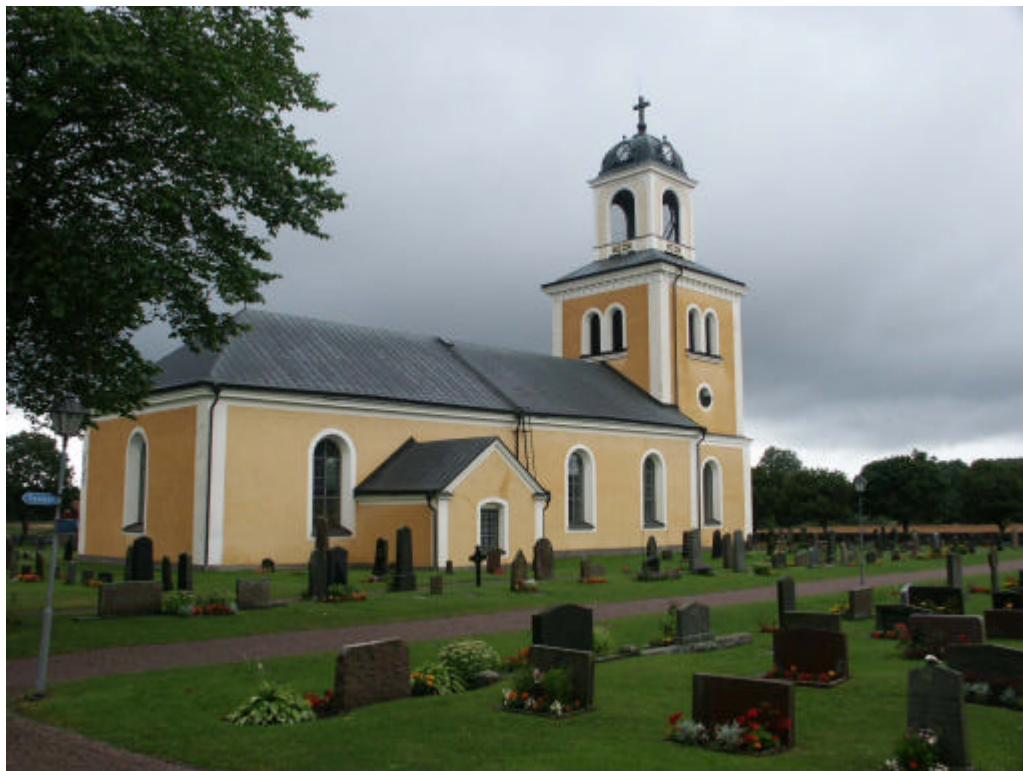
Börstils kyrka och kyrkogård, vy från nordost. Utvändigt präglas den starkt av ombyggnaden 1850-52 då tornet uppfördes och kyrkan fick karaktären av nyklassicistisk salkyrka.
